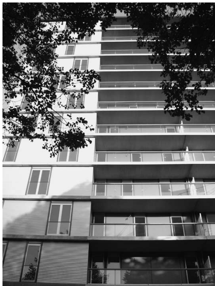
Nieuwbouwproject De Stadstuinen in Osdorp.
