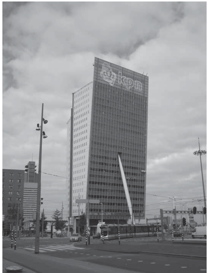
KPN-gebouw op de Kop van Zuid, Rotterdam.
