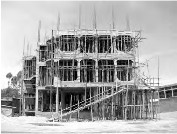
kantoor van handelsvereniging FEC in aanbouw
