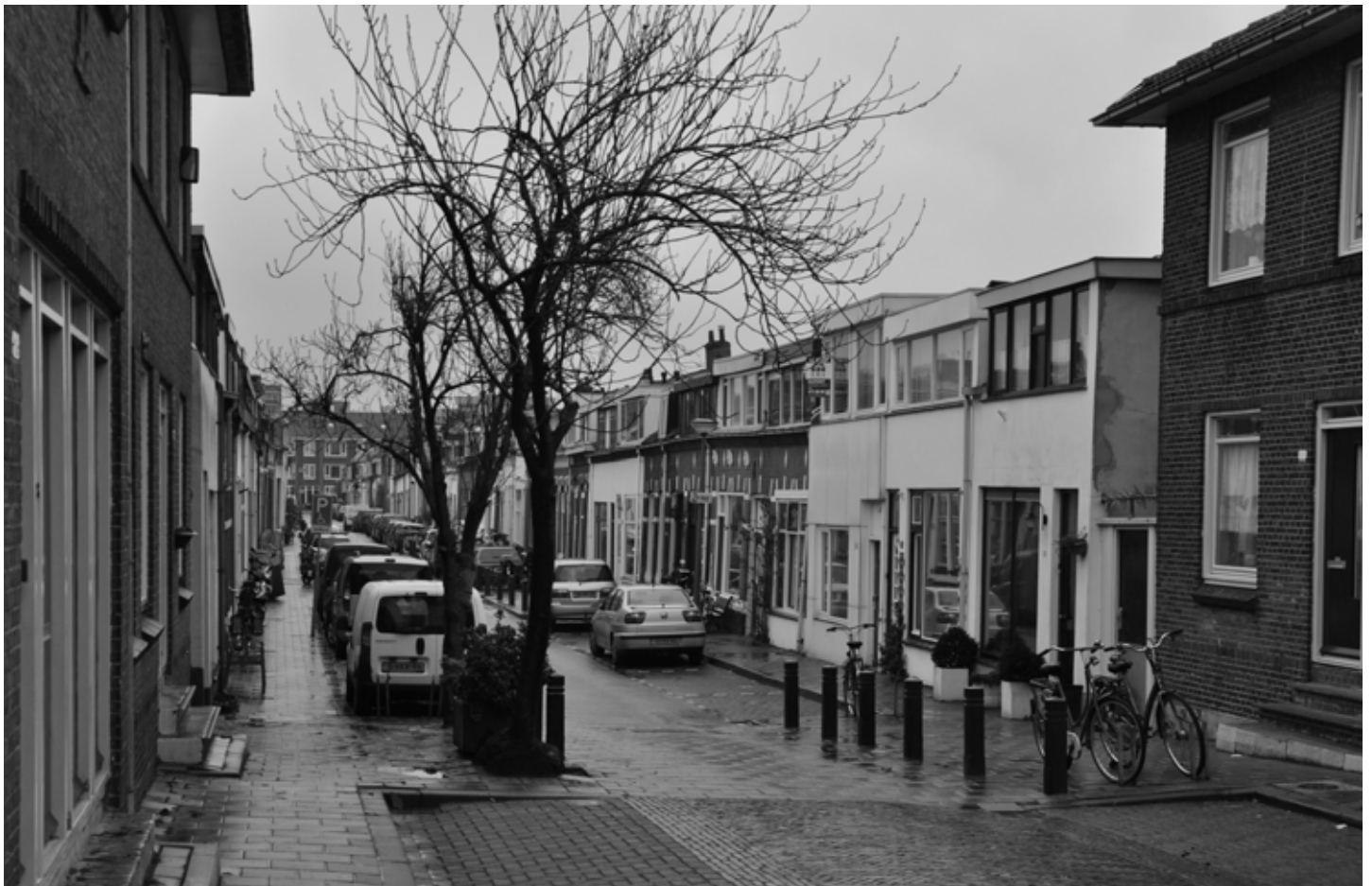
De vooroorlogse arbeiderswoningen in de Villastraat in Schiedam-Oost hebben te kampen met verzakking
