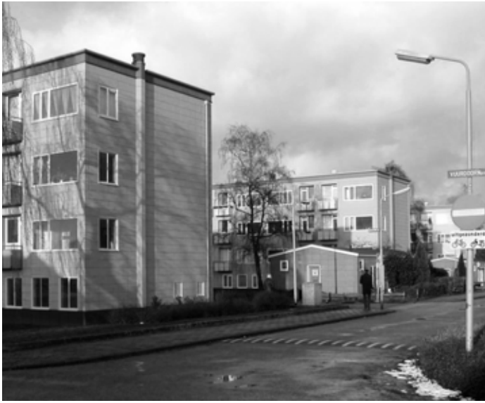
Airey-woningen, een type montagebouw dat kort na de Tweede Wereldoorlog veel werd toegepast, in de wijk Heseveld in Nijmegen.
