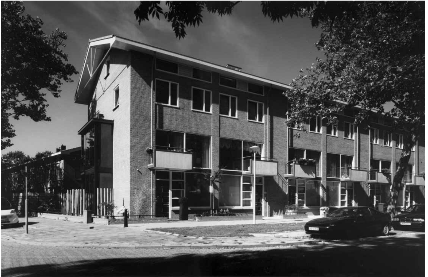
Assumburgweg, Den Haag, dertig eengezinswoningen, voorgevel stadswoningen
