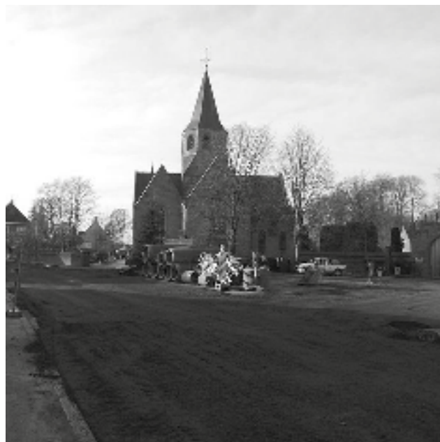
Klassieke heraanleg riolering en plein Schelderode.
